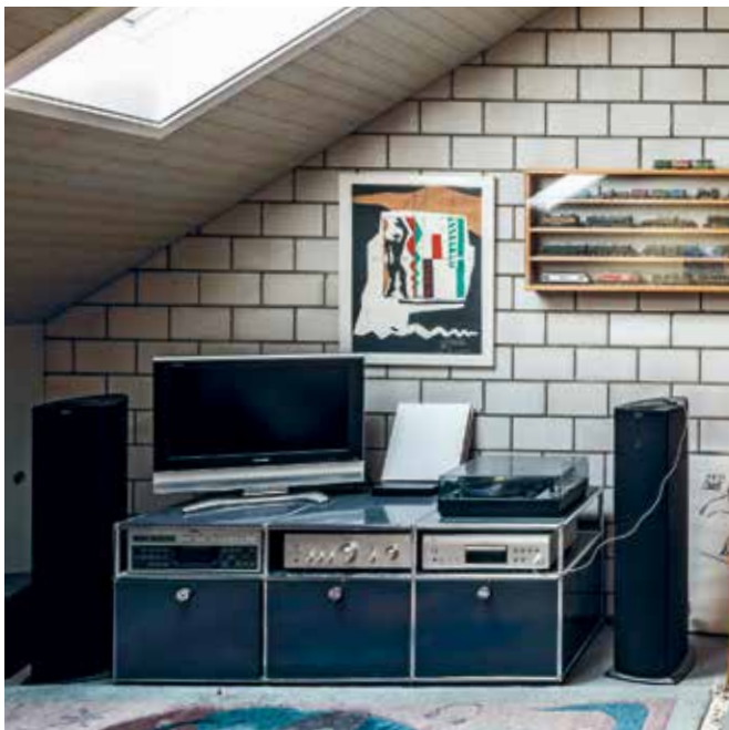
Sichtmauerwerk Wanddicke 100–200 mm Dämmwerte R'w dB 46–52
