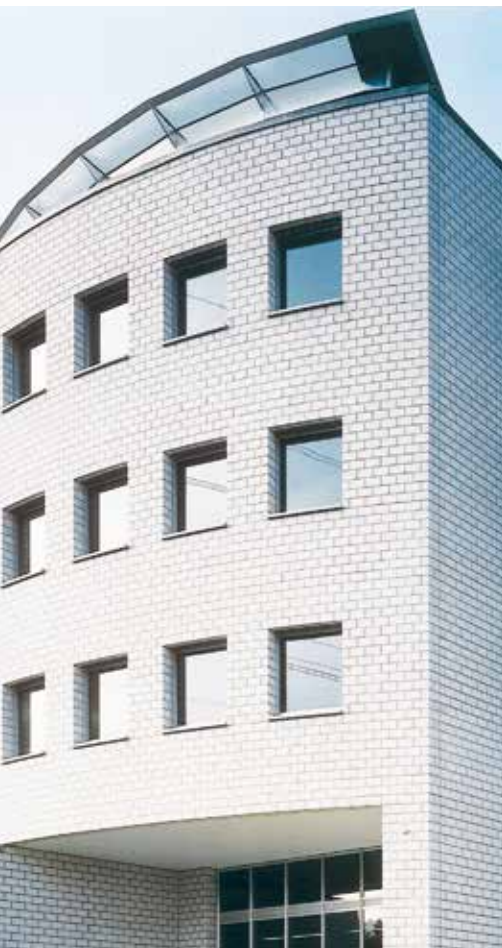
Läuferverband Steinhöhe 14 cm
